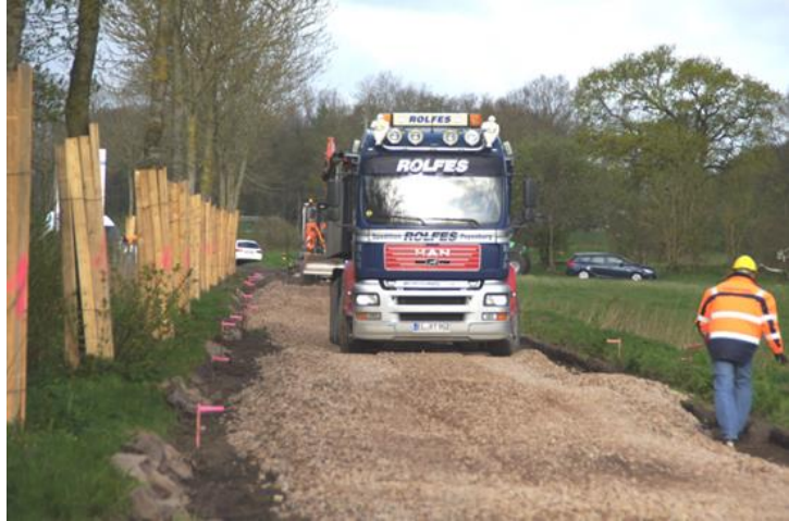
Sanierung „Schulweg“ in Diele
